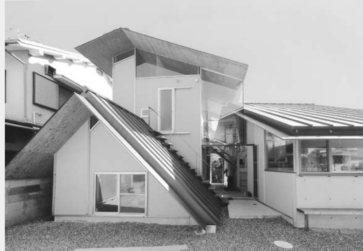
北側からの外観
