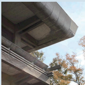
改修前の南西側出隅部
