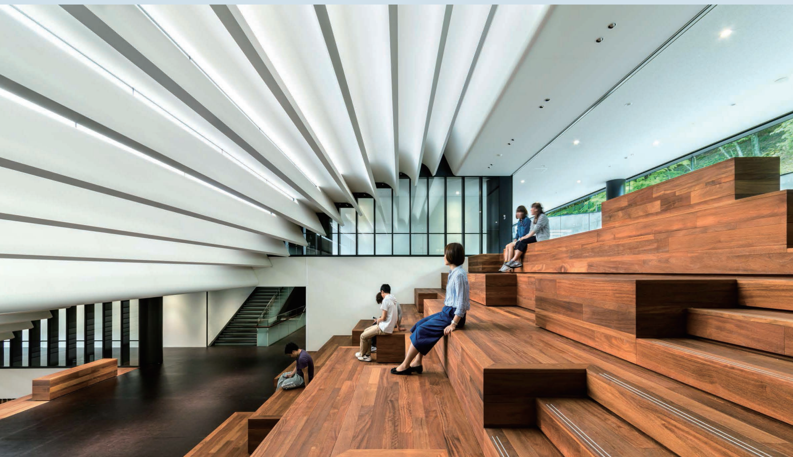
光を導くPC大階段を屋根とし自然光で明るい段状ラウンジ
