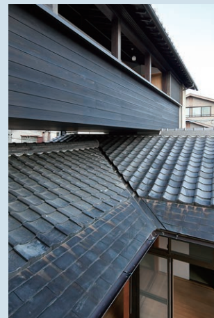
既存屋根と新設の二階
